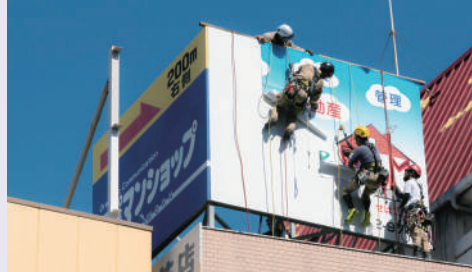
サイン業界で懸念されがちな安全面においても、空中養生の設置を検討するなどして、模索が続けている
