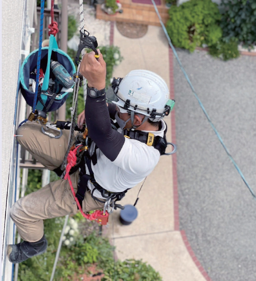
高い場所であっても、足場を使わずに作業可能。ロープ施工は、ローコストかつ短納期を実現する
